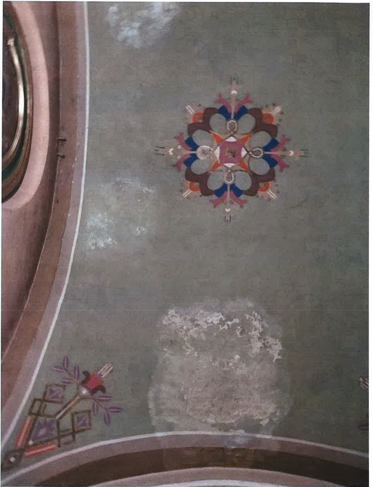
Fot. 36. Tarnawa Dolna. Kościół parafialny p.w. Św. Jana Kantego. Wnętrze. Fragment sklepienia nawy bocznej po stronie północnej widoczne zniszczenia warstwy malarskiej spowodowane zalaniem wodą deszczową.
