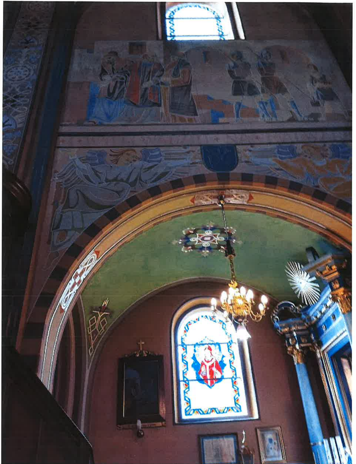
Fot. 14. Tarnawa Dolna. Kościół parafialny p.w. Św. Jana Kantego. Wnętrze. Nawa główna, ściana tarczowa po stronie północnej widoczne zabrudzenia powierzchni i złuszczająca się warstwa malarska. ( z boku anioła w sąsiedztwie ambony)
