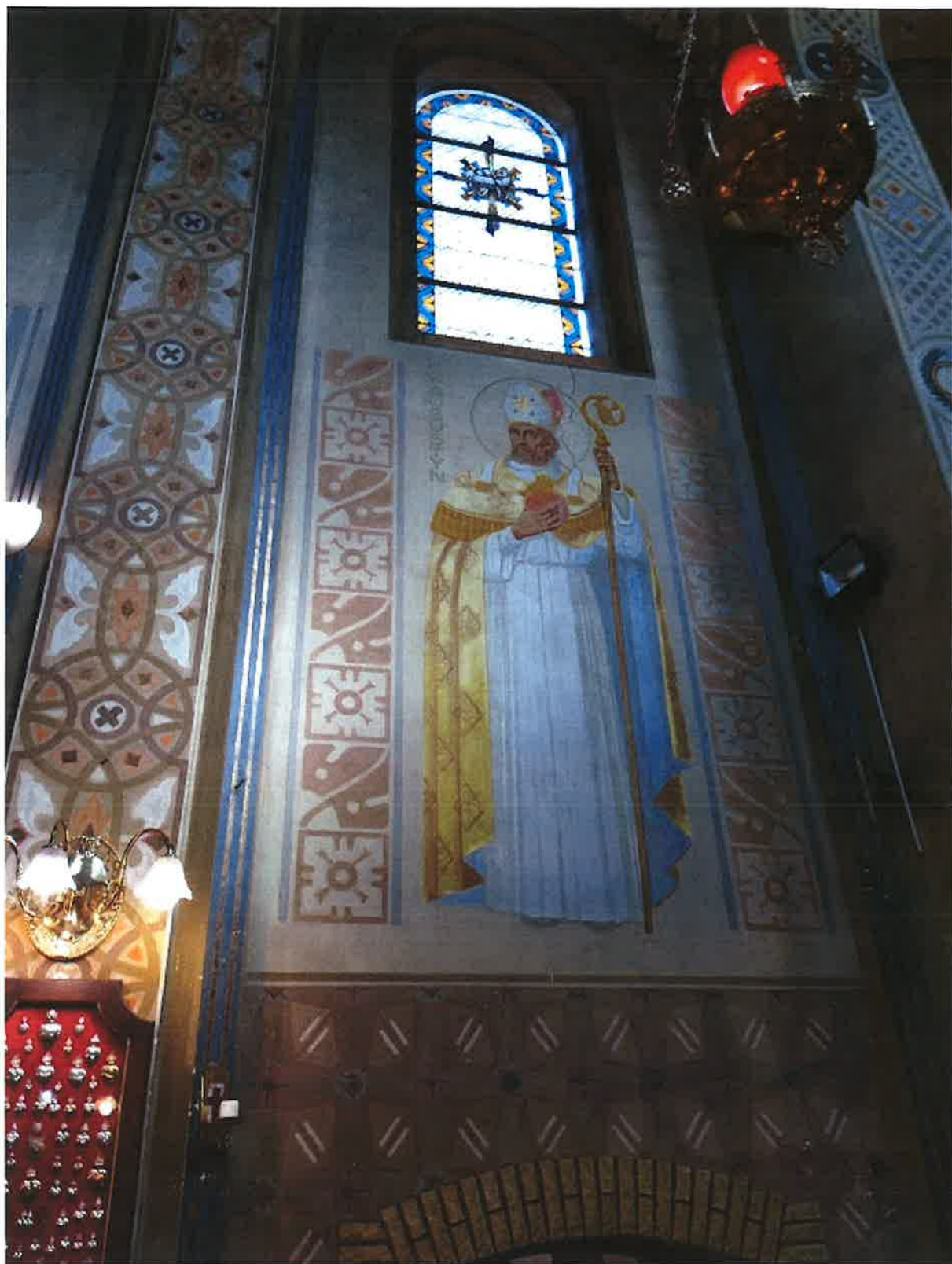
Fot. 23. Tarnawa Dolna. Kościół parafialny p.w. Św. Jana Kantego. Wnętrze prezbiterium. Fragment ściany tarczowej w sąsiedztwie tarczy po stronie północnej z wizerunkiem dra kościoła św. Augustyna . Widoczne zabrudzenia powierzchni polichromii oraz odpryski warstwy malarskiej i dolnej partii ściany
