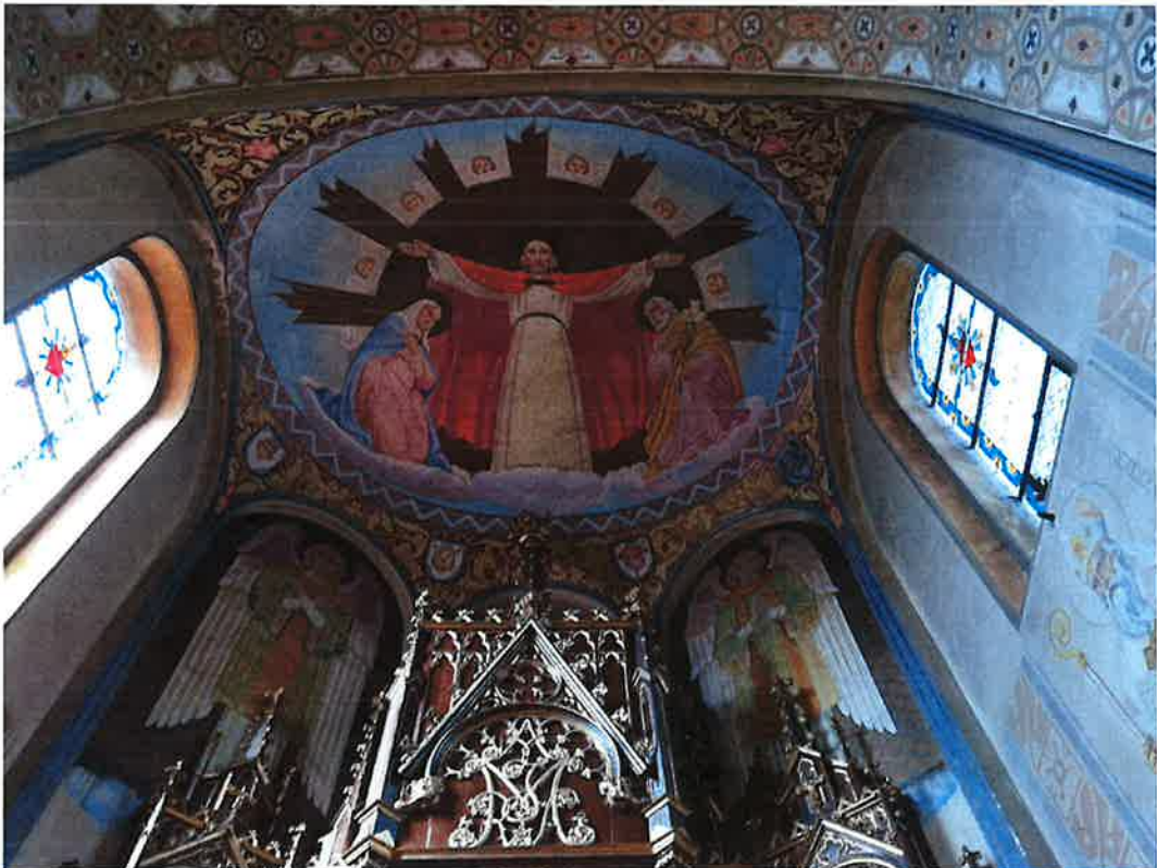
Fot. 17/18. Tarnawa Dolna. Kościół parafialny p.w. Św. Jana Kantego. Wnętrze. Prezbiterium fragmenty sklepienia . Widoczne zaplamienia i zabrudzenia powierzchni polichromii oraz odpryski warstwy malarskiej.
