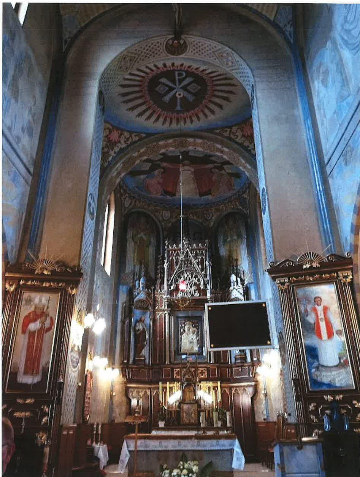
Fot. 4. Tarnawa Dolna. Kościół parafialny p.w. Św. Jana Kantego. Wnętrze. Nawa główna, ściana tęczowa, zbrudzenia powierzchni, nieczytelne napisy umieszczone wokół luku tęczy po obu stronach krucyfiksu.
