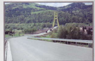
Obwodnica w budowie
