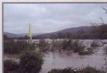
Powódź - widok na Nowy most
