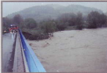
Powódź - ratowanie mostu na Pałeczce
