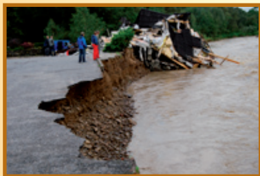
Powódź - zniszczony zajazd "Zielona Gęś"
