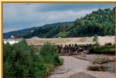
Podmyte tory kolejowe w Tarnawie Dol.
