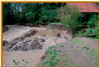
Podmyty dom mieszkalny w Tarnawie Dol.
