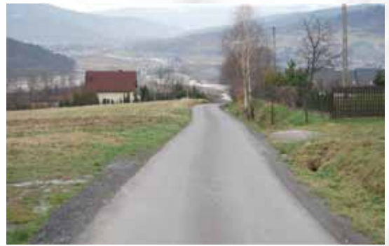
Droga na Niziej w Tarnawie Dolnej
