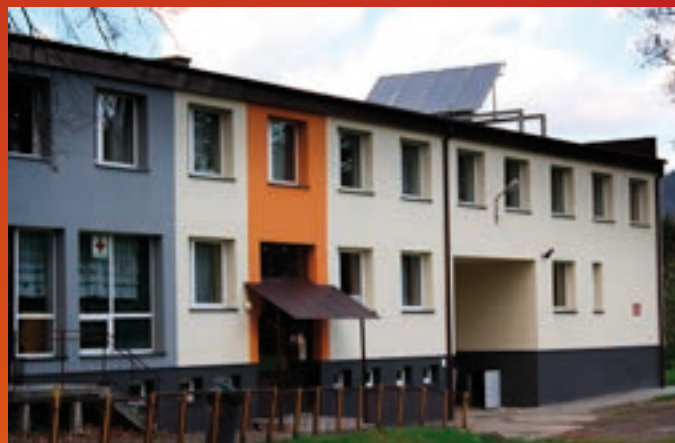
Termomodernizacja budynku Pawilonu sportowego w Zembrzycach
