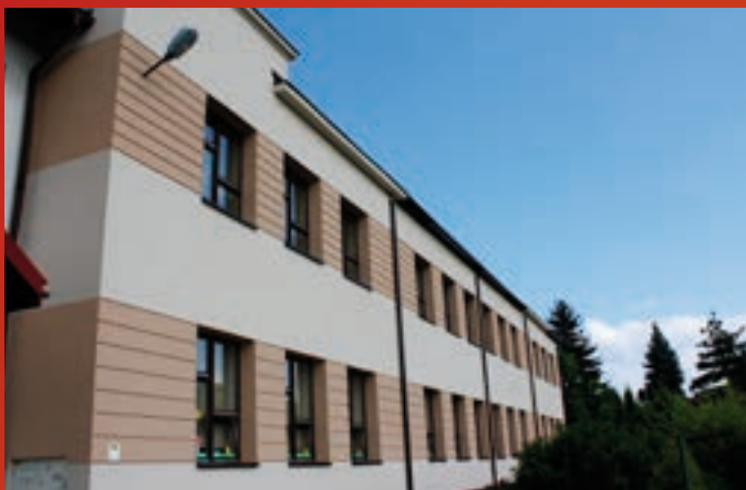
Odnowiony budynek ZS w Zembrzycach
