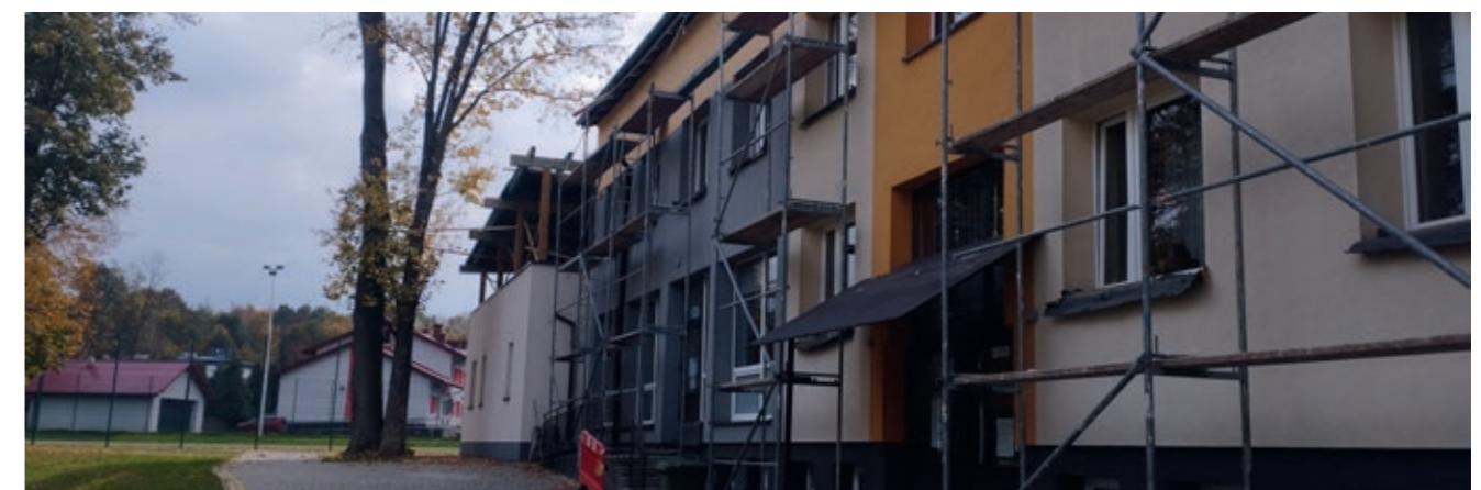
Nadbudowa budynku Centrum Rekreacji i Wypoczynku w Zembrzycach
