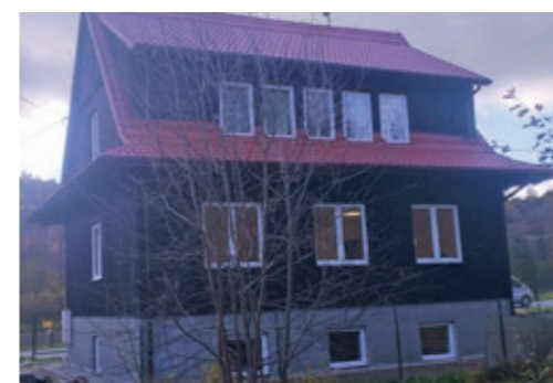
Remont budynku Świetlicy wiejskiej Tarnawa Górnej
