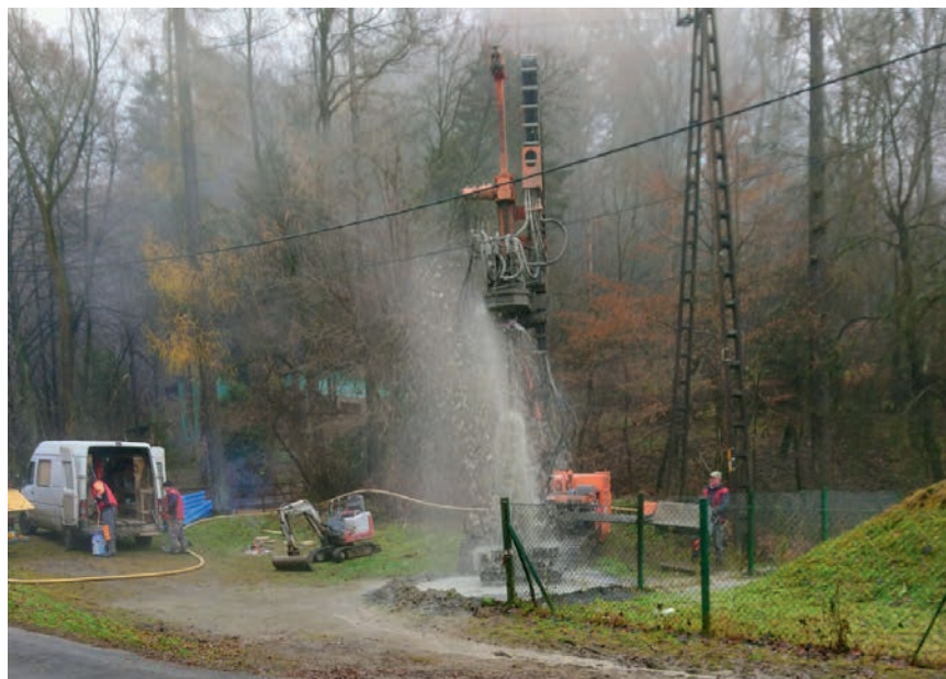
Wykonanie odwiertu eksploatacyjnego Nówka S-2 w Zembrzycach
